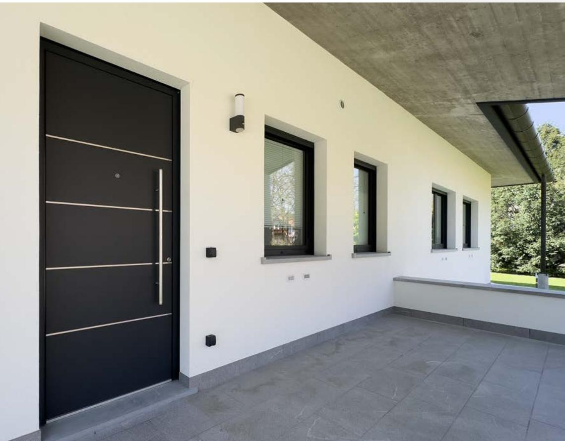
Ogni apertura è stata studiata e realizzata con **serramenti in alluminio a taglio termico di nostra produzione**, progettati su misura per rispondere a specifiche esigenze tecniche e climatiche.
